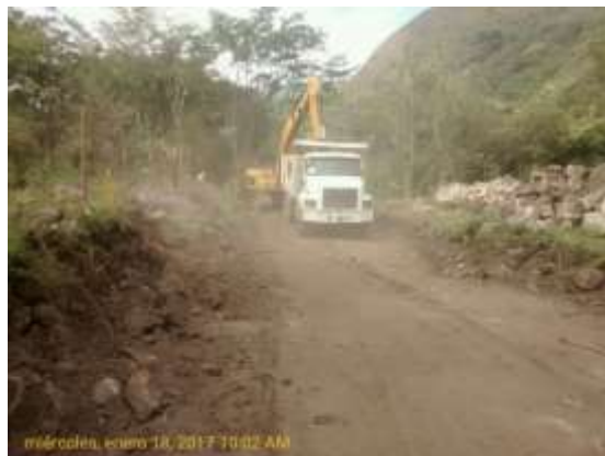
Fotografía 8.7 Manejo de sobrantes de excavación.
