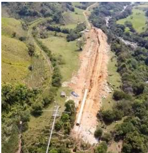
Vista en planta de las excavaciones para conducción (PCH Cantayús)
