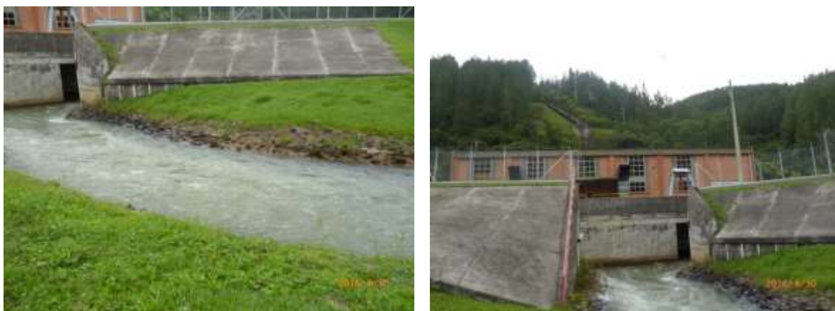
Fotografía 8.9 Ejemplo de conducción del caudal remanente, PCH La Herradura.
