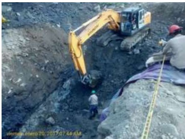
Excavación mecánica (PCH Juan García)
