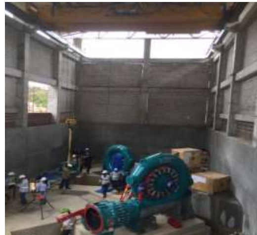
Instalación de turbinas (PCH Cantayús)
