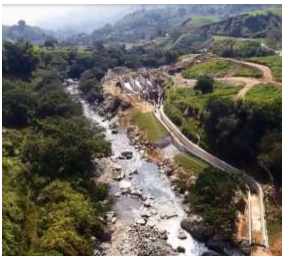
Desarenador y canal de purga (PCH Cantayús)
