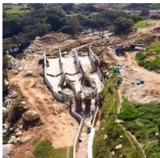
Desarenador (PCH Cantayús)
